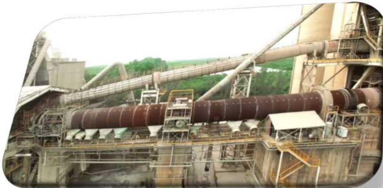
Lò nung tại Công ty TNHH Siam City Cement (Việt Nam)
